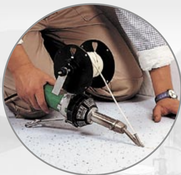
Spawanie na gorąco wykładziny
