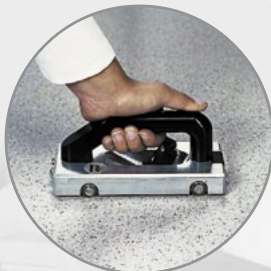
Frezowanie wykładziny
